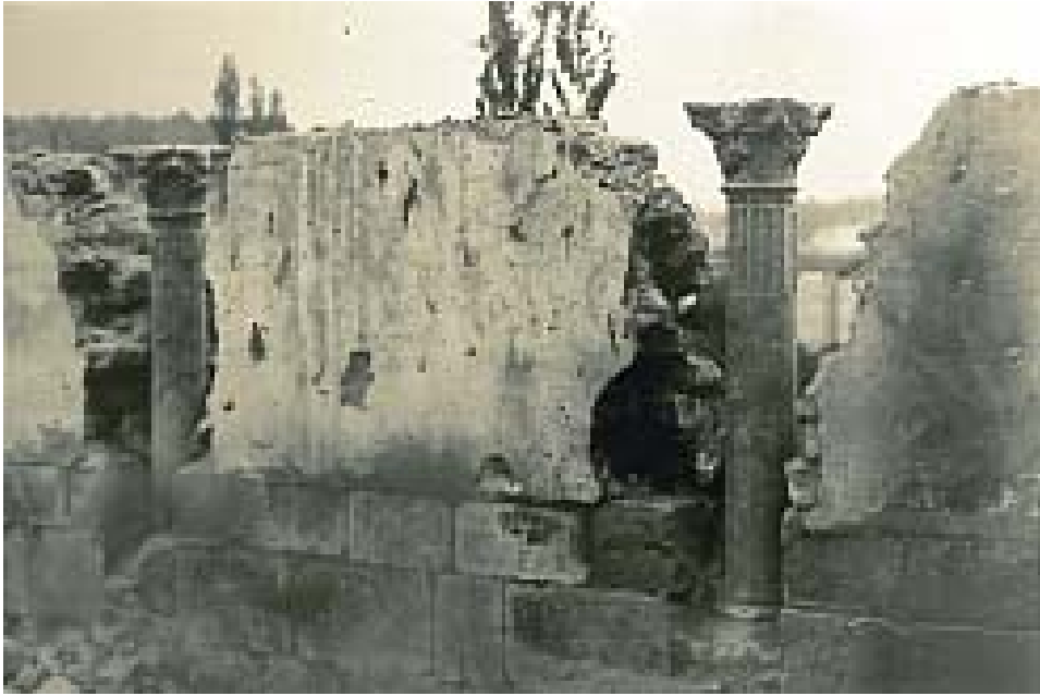
Columnas romanas de la desaparecida “Poza”.
