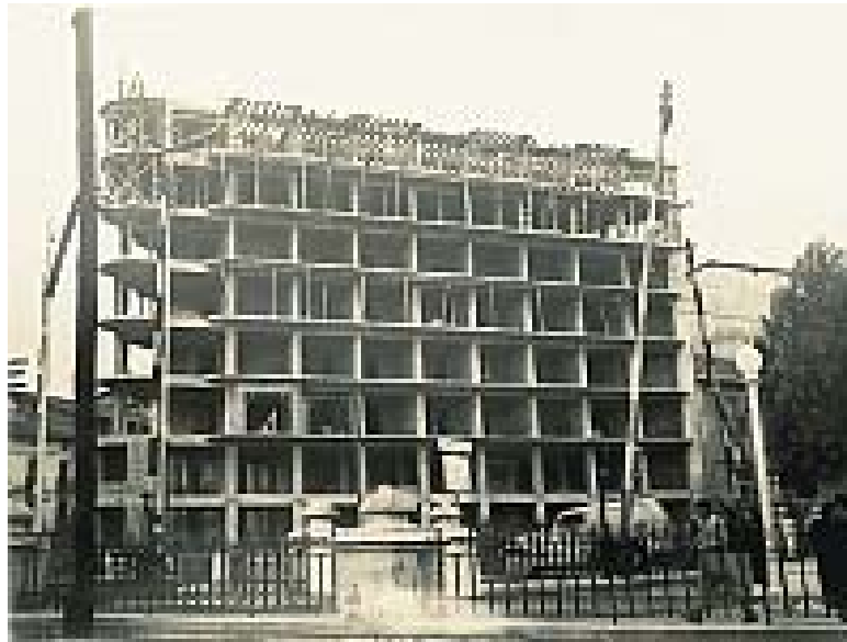
Construcción del Banco de Bilbao.
